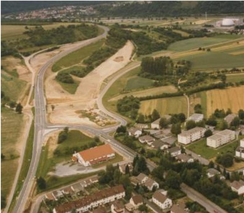
Abb. 5: Baustelle Hohbergaufstieg August 1988: Gut ist die gefälligere Trassenführung durch Abschneiden einer Kurve zu sehen.
