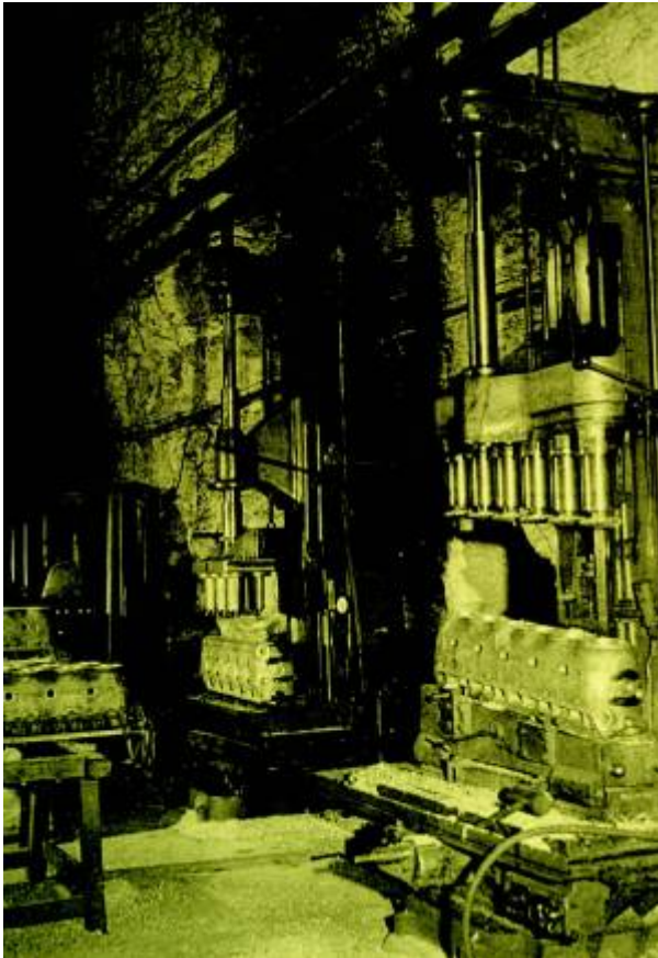
Zylinderbohrmaschine für die Motorenfertigung im Stollen GOLDFISCH, 1944/45
