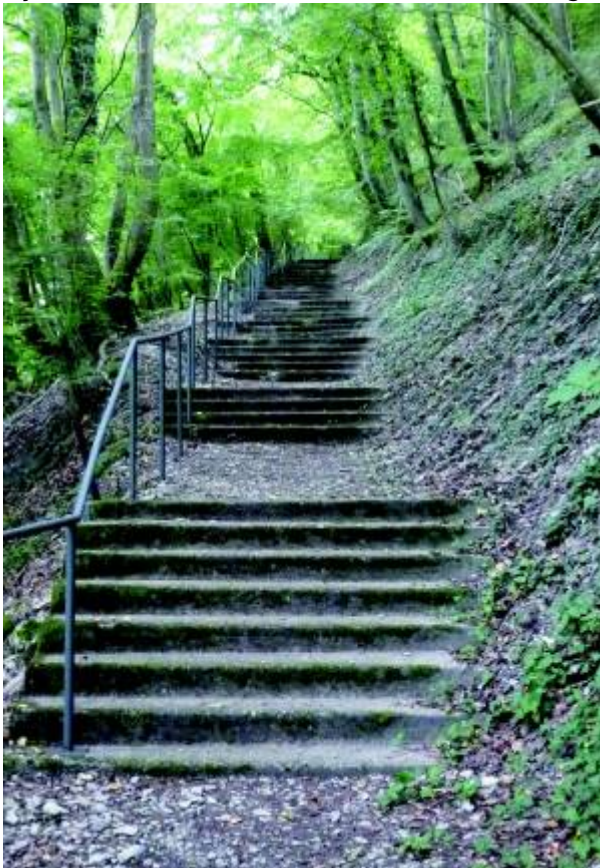
Treppenweg zum Stollen GOLDFISCH, erbaut von KZ-Häftlingen im Frühjahr 1944
